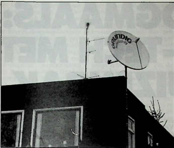
Afb. 2. De bijbehorende antenne (Hutronic) met Polar-mount (Rovasan), elektrische afstandbediening en polariteitswisselaar. Gemonteerd op het dak van Evenhuis en Amerika te Eelde.
